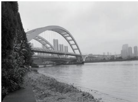
桥梁、隧道变形监测
